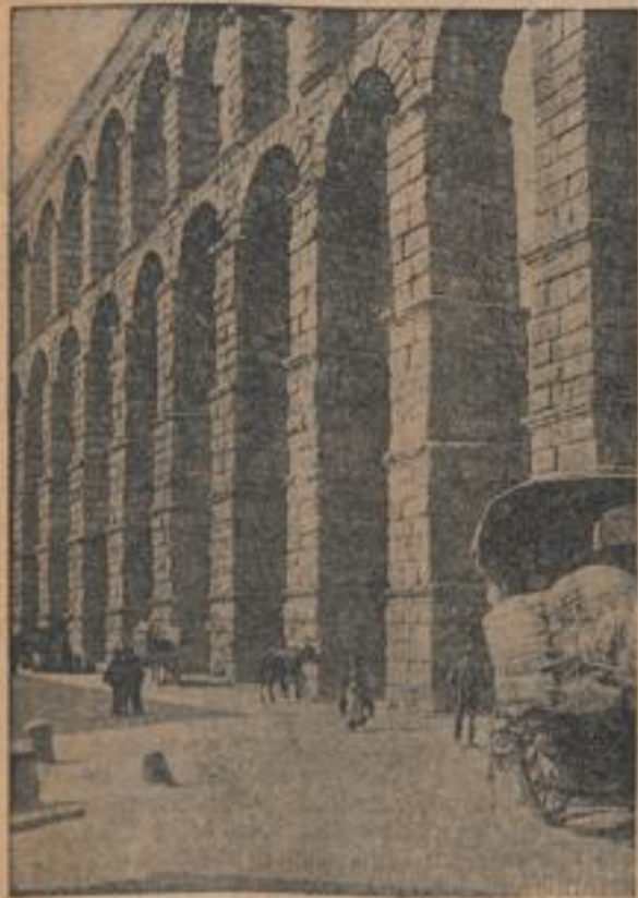
Der Kanaldamm von Segovia.
