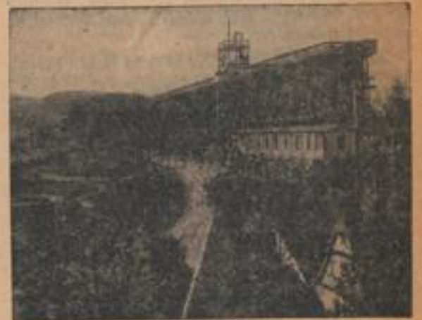
Das Gradierwerk einer Salzsole
