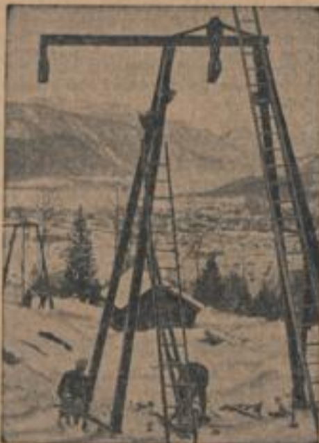
Neuer Bauzug von Garmisch- Partenkirchen zur Neunerhütte Die Wagen für den Bauzug, der etwa Mitte September in Benutzung genommen werden soll, werden erstrahlt. (Schirner, Zander-Multiplex-R.)
