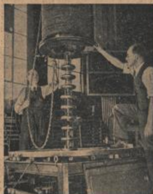
Das ist die größte Röntgenröhre der Welt In Schenectady (USA) nähern sich die Arbeiten an der größten Röntgenröhre der Welt ihrer Vollendung. Die Röhre misst 1 Mill. Volt. (Associated Press, Zander-M.)
