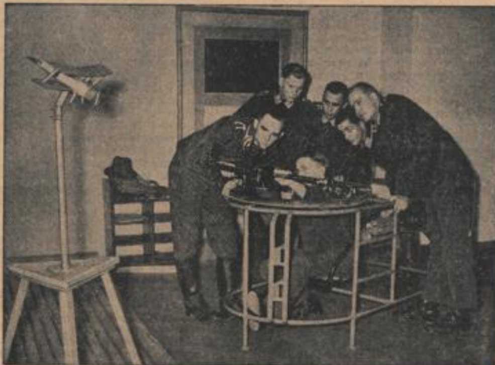
Deutsche Kampfflieger in der Schule Ein Bild aus der Kampffliegerschule Luton in Hannover. Von einem Maschinensteuertisch aus, der der gleiche wie in einem Flugzeug ist, wird nach einem Modellflugzeug geschossen. (Zitner, Zander-M.)
