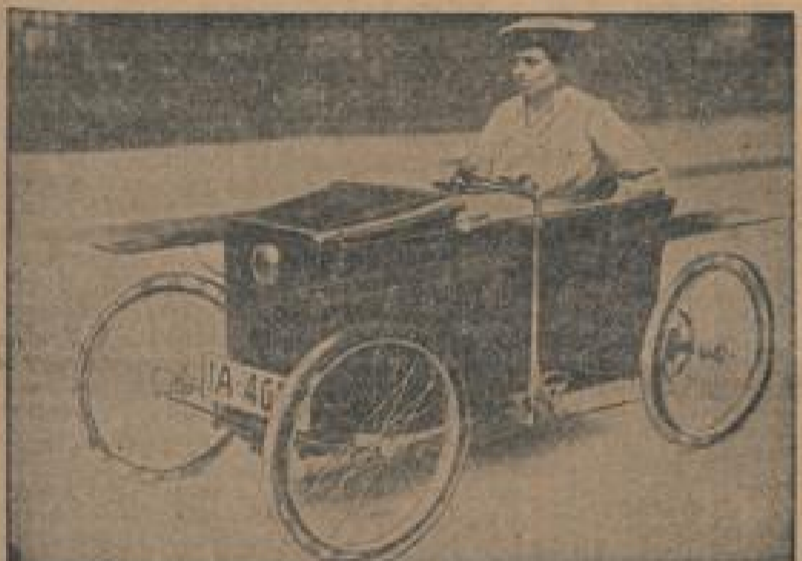
So stellte man sich 1919 das kleine und sparsame Personenauto vor. Als Folge der durch den Krieg hervorgerufenen Gummiknappheit hat es noch Eisrollen mit Federtöpfen
