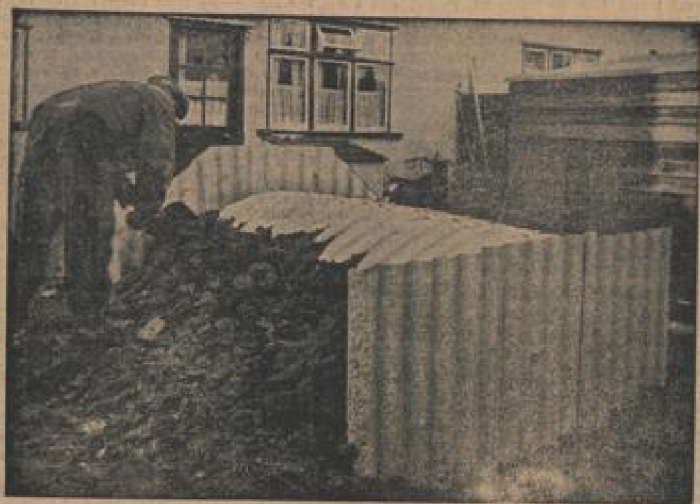
Ein Luftschutraum wird mit Sand befüllt
