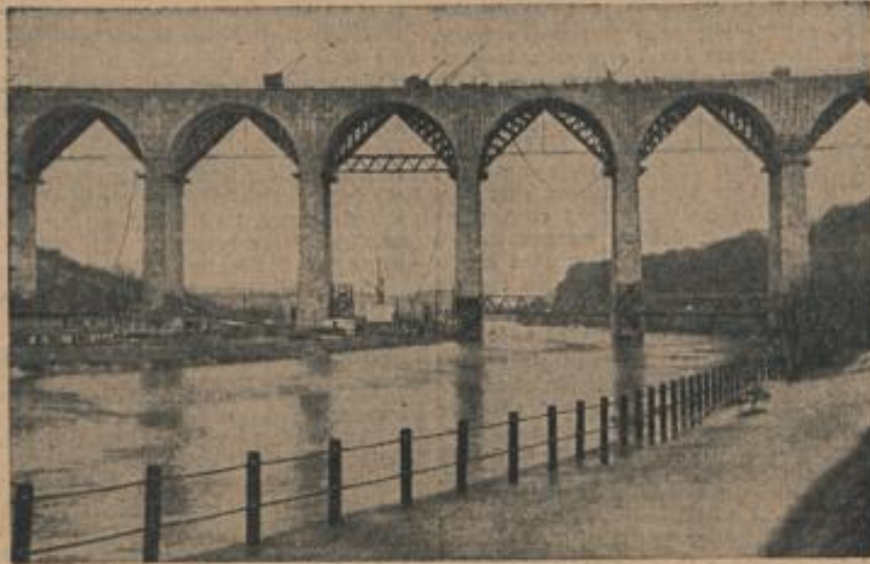
Die Reichsautobahnbrücke bei Limburg vor der Vollendung Die wichtige Teilstrecke der Reichsautobahn Frankfurt-Rhein nähert sich mehr und mehr ihrer Sollenbahn. Unter Bild zeigt den größten Brückenbau im Verlauf dieser Teilstrecke, die Autobahnbrücke, die sich 65 Meter über den Wasserpiegel erhebt, und bei einer Breite von 19 Meter 500 Meter lang sein wird. (Vogel-Bild-Zentrale, Jander-Multiplex-R.)
