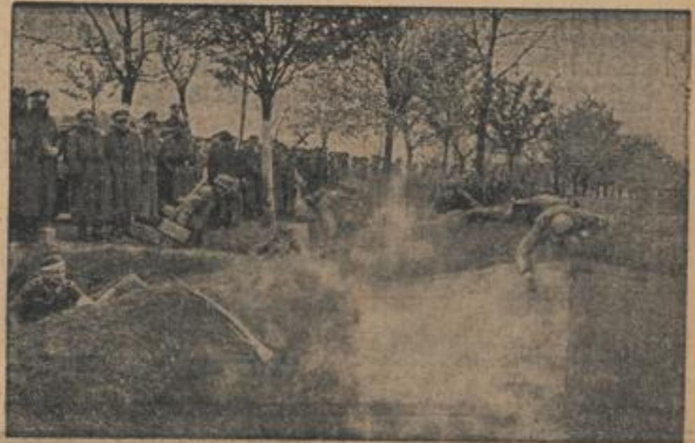
Wohin sollte eine Panzerkolonne überrennen und einen Turmstock erzwängen. Pioniere sollten unter allen Umständen an den äußersten Punkt herankommen und ihn mit geballten Ladungen und unter Einsatz von Kampfwerkzeugen außer Betrieb setzen. Der Turmstock überlagert das Straßennetz im Hinterland der Panzerweil: gutachten.
