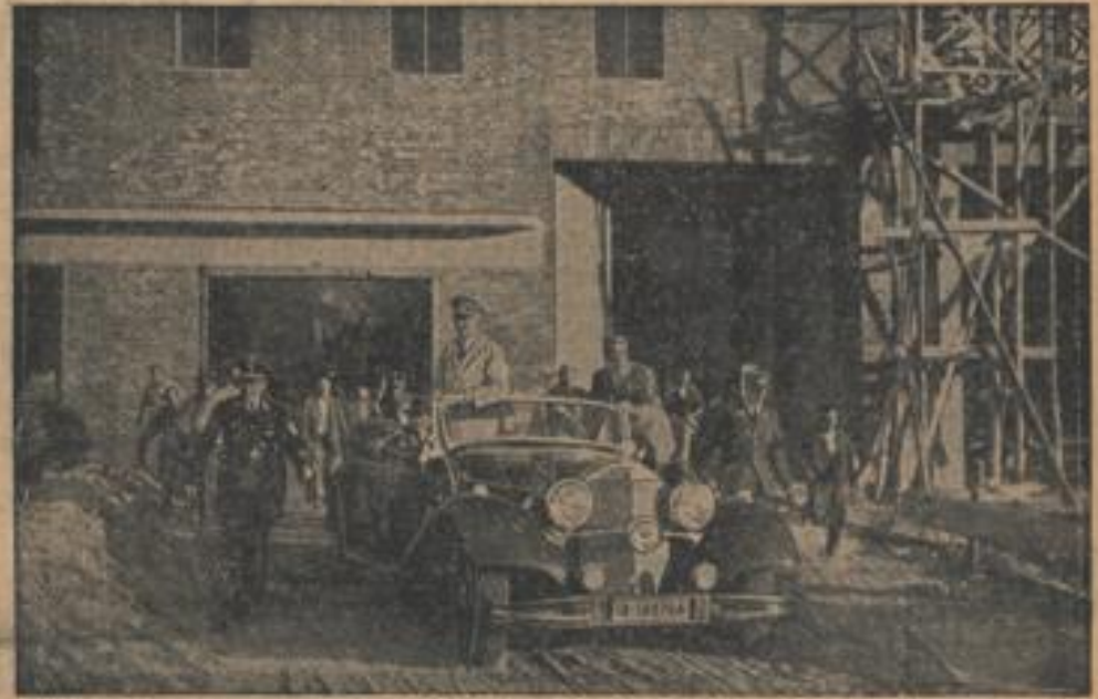
Der Führer hatte sich unerwartet dem im Bau begriffenen Volkswagenwerk Fallerleben einen Besuch ab, um sich vom Fortschritt der Arbeiten zu überzeugen.
