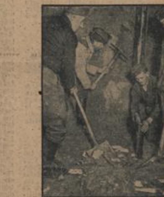
Stollenbau an der Westfront Es handelt sich um einen Stollen, der zu einem Artillerieunterstand vorgelassen wird. (Atlantik, Jander-Multiplex-R.)
