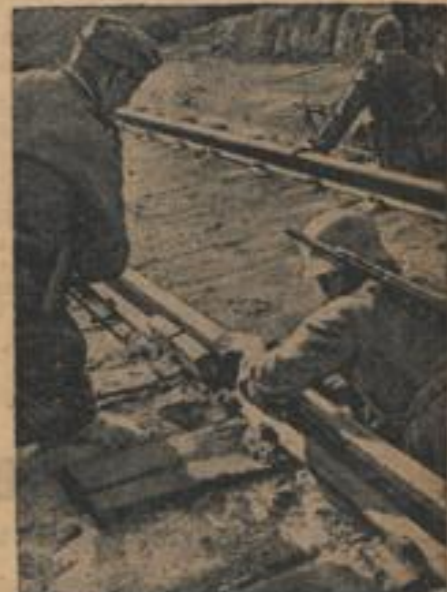
Pioniere sprengen eine Eisenbahnbrücke und machen dadurch einen Transportweg der Sowjets, der für den feindlichen Nachschub wichtig war, unbrauchbar. (Fotografie: Kriegsberichterstatter, SS, Sander-Multiplex-Druck.)
