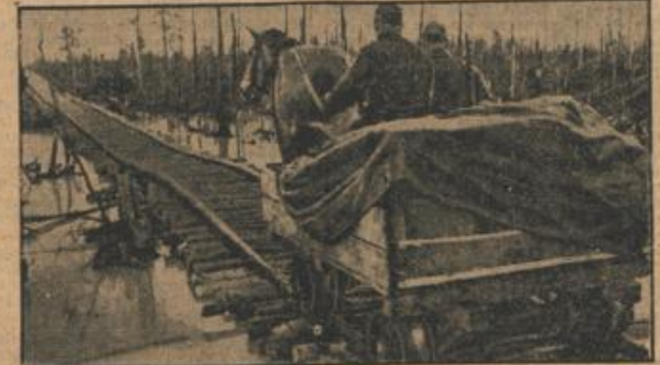
Die Moorbahn ist fast vollständig aus dem Baustoff der großen Wälder Russlands gebaut. Sie bildet eine einfache und leicht zu reparierende Verbindung zwischen der Hauptkampflinie und den Nachschublinien. (PK-Aufnahme: Kriegsberichterstatter Rynas, All. Z.)
