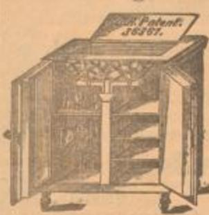
Deutsches Reichspatent Nr. 36367 Italienisches Patent Nr. 20291. Bei diesem neuen System wird bei beträchtlicher Eisersparnis, weil das Eis oben frei im Schranke liegt, eine größere und raschere Kälte erzielt, ebenso ist die Ventilation eine verbesserte. 4574 Lager in 14 verschiedenen Größen, zu allen möglichen Zwecken geeignet.
