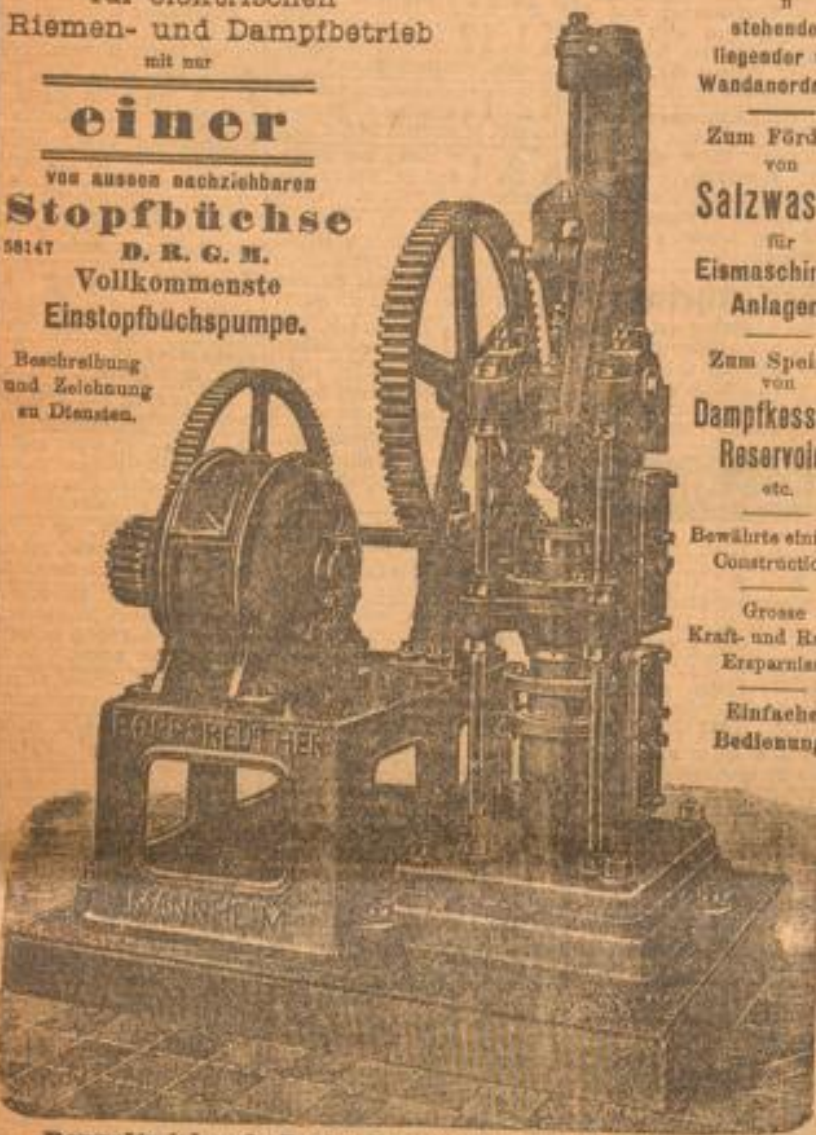
Doppeltwirkende Speise-Pumpe mit elektrischem Antrieb.
