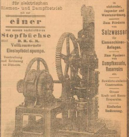
Doppeltwirkende Speise-Pumpe mit elektrischem Antrieb.
