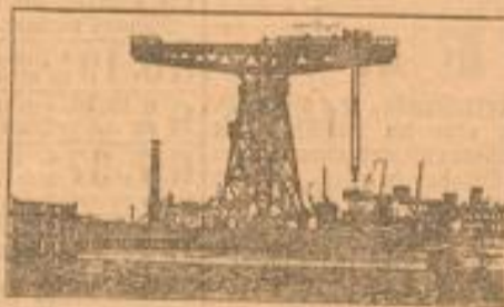
Riesenkrahn 150000 kg. Tragkraft.
