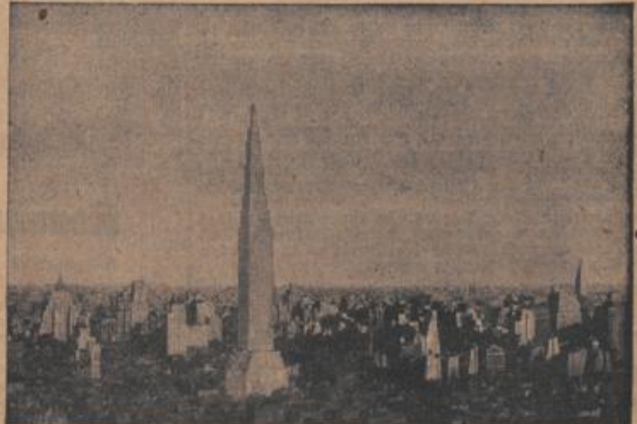
Das größte Gebäude der Welt, der im Bau begriffene Lankin Tower in New York, mit 110 Stockwerken. Presse-Photo
