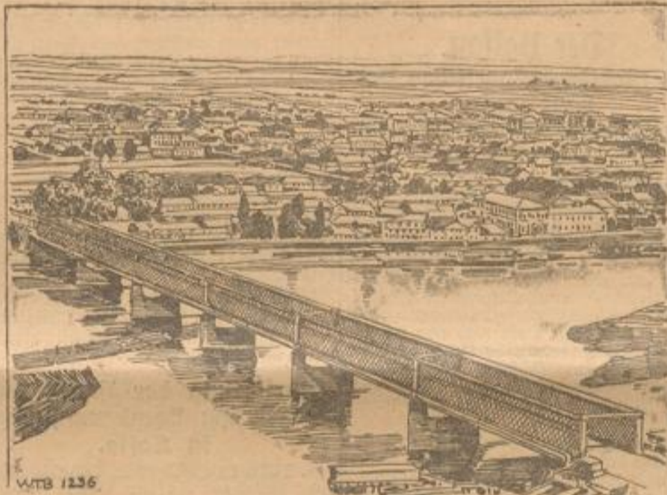
Die Warschauer Vorstadt Praga mit der imposanten Eisenbahnbrücke über die Weichsel.
