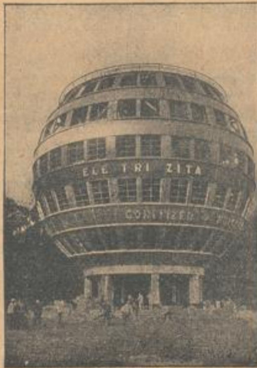
Von der Dresdner Ausstellung: „Die technische Stadt“. Das erste Kugelhaus der Welt. Seine Größe entspricht dem Höhen- verhältnis der Bavaria in München. Während im unteren Teil des Kugelhauses in 4 Etagen Geschäftsläden eingerichtet werden, befindet sich in seinem oberen Teil unmittelbar unter der Kuppel ein Kaffeerestaurant, zu dem eigene Aufzüge hinaufführen. Deutsche Presse-Photo-Zentrale Berlin.
