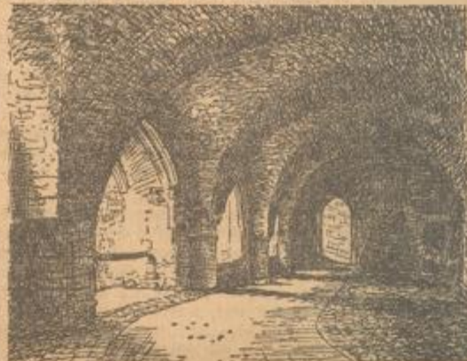
Gewölbe unter der Schloßterrasse
