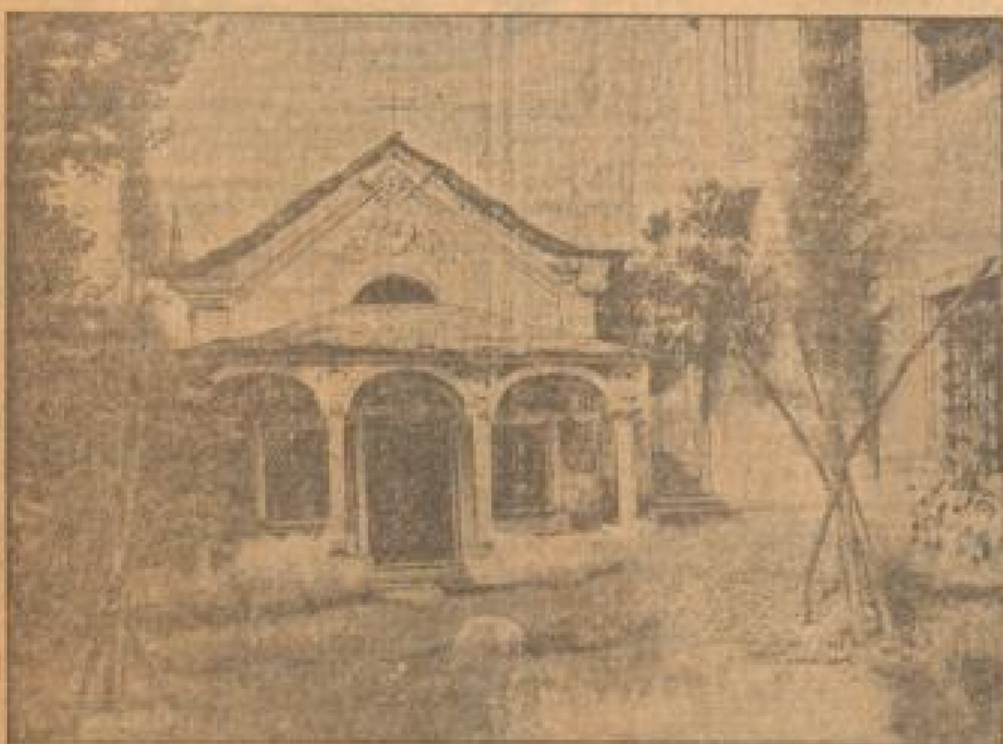
Die Kirche „S. Maria di Piazza“ in Locarno ist von Architektenkreisen erworben und nach archaischen Vorbildern als „Tempel des Friedens“ zur Erinnerung an die Konferenz in Locarno im Jahr 1924 erbaut worden. Die Kirche war früher ein bekanntes Wallfahrtsort und wurde nach Zerstörung von Bomben, Brand und Schmelzen neu erbaut.
