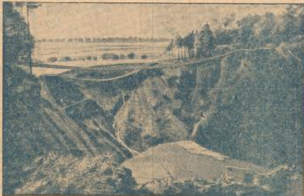
Immer tiefer senkt sich der Riesenerker an der Eisenbahnstrecke von Vienenburg
