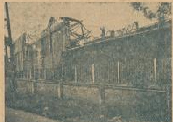
Der eingestürzte Laufkran am Weinheimer Weg
