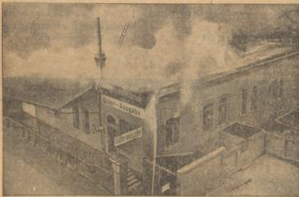
In dem von Fritz Langen Werkstätten des Wärrschloßhofs von Hannover stand ein Feuer aus, das durch Niesen- und Obleibungen von Wintermägen (siehe eine Wintermaikäfer-Larve) entstand und die Gebäude zerstörte. Der Brandschaden geht in die Millionen.
