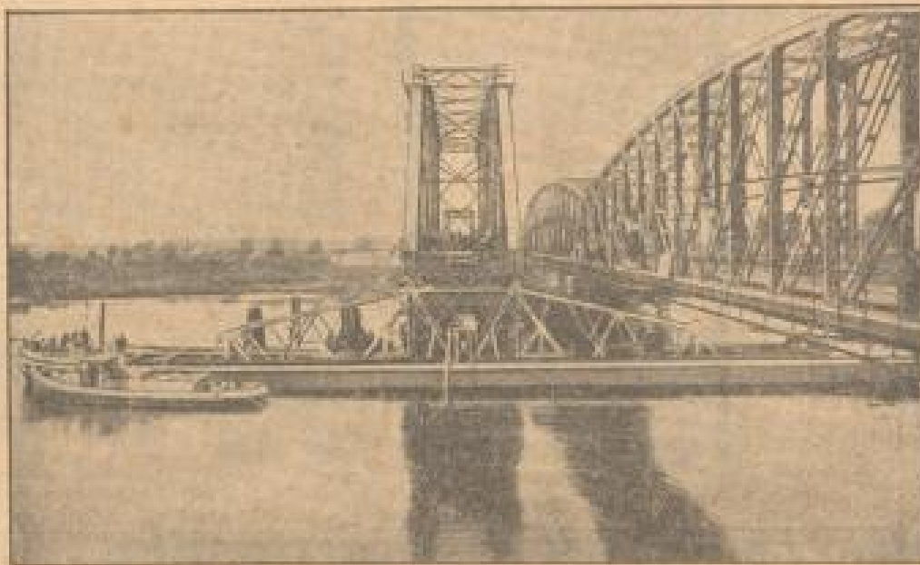
Die Oberbrücke bei Böhmerwald vor der Fertigstellung
