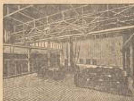
Blick in die Maschinenhalle
