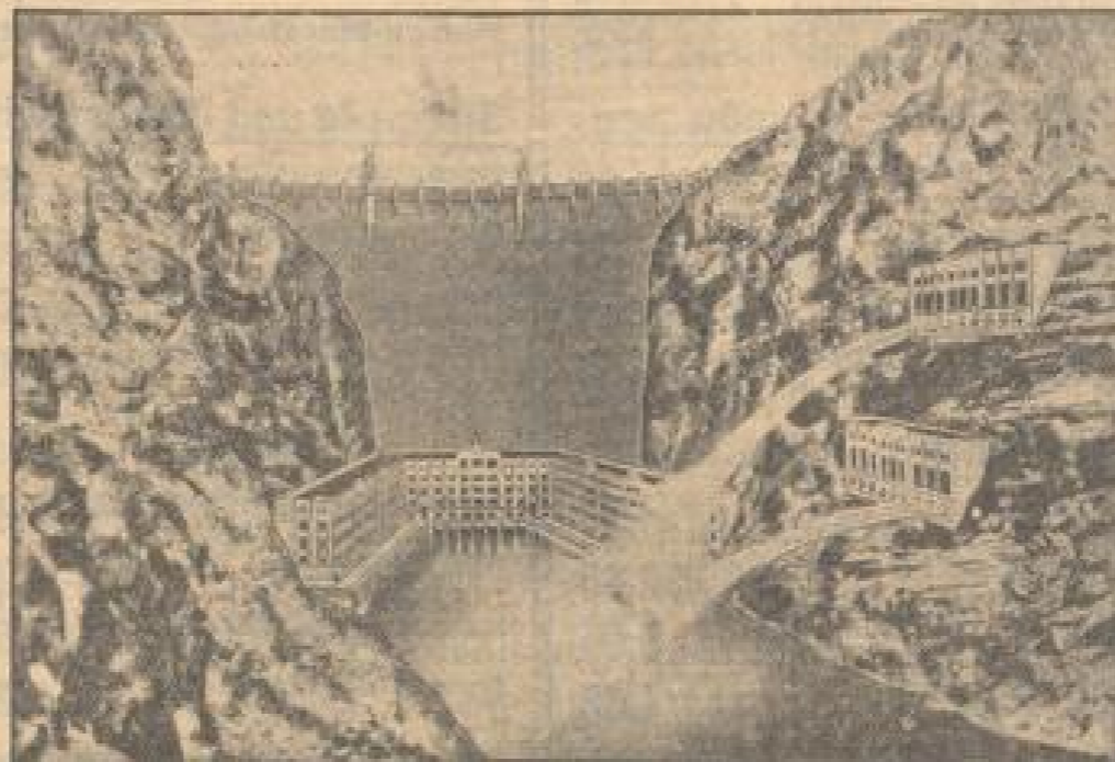
Stätte des im Bau befindlichen Hoover-Staudamms in den Vereinigten Staaten, der 1931 in Betrieb genommen werden soll. Das ungeheure Werk, das nach Fertigstellung bald Amerika mit elektrischem Strom versorgen wird, ist wohl das großartigste Projekt seit dem Bau des Panamakanals.
