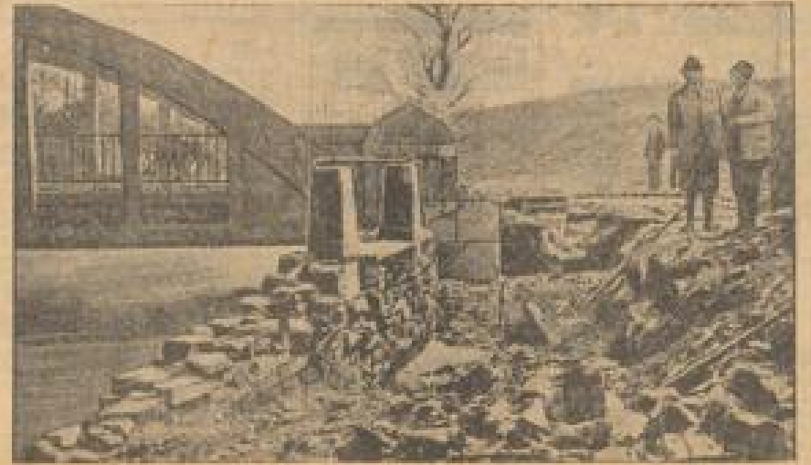
Das zerstörte Ufer der Elbe bei Bergheim in der Nähe von Karlshöhe
