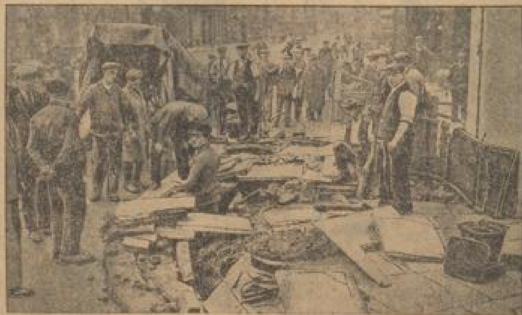
Erdbeben verursacht Zerstörungen in Londoner Straßen
