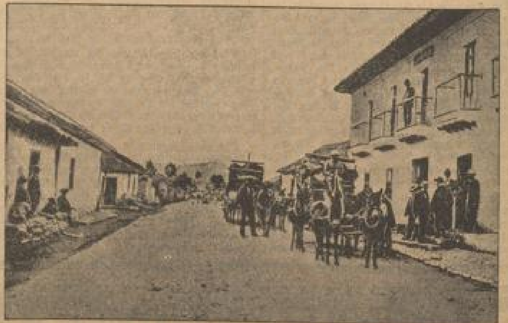
Die Hauptstraße von Quito (Ecuador), die völlig zerstört wurde
