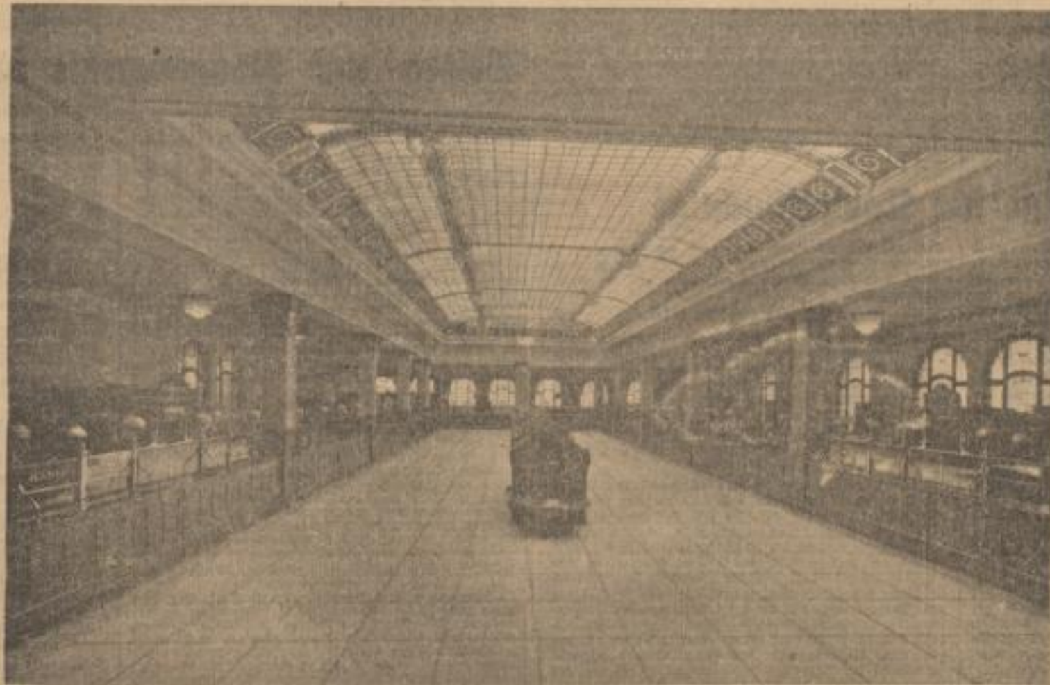
Schalterraum der Städtischen Sparkasse A 1, 2/3 u. 6/8
