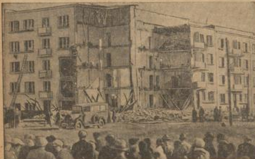
Der zerstörte Reubanblock
