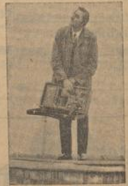
Ein Heberwahnquartier bei der Arbeit am Turm
