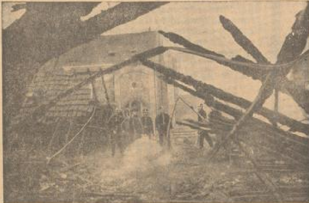
Die Feuerwunde bei den Wärdarbeiten auf dem niedergebrannten Jagdschloß in Brühl bei Köln. Das Jagdschloß des ehemaligen Königlich Preussischen Königs in Brühl bei Köln wurde von einem verheerenden Brand heimgesucht. Das über 200 Jahre alte Hoflojagdschloß wurde fast vollständig zerstört.
