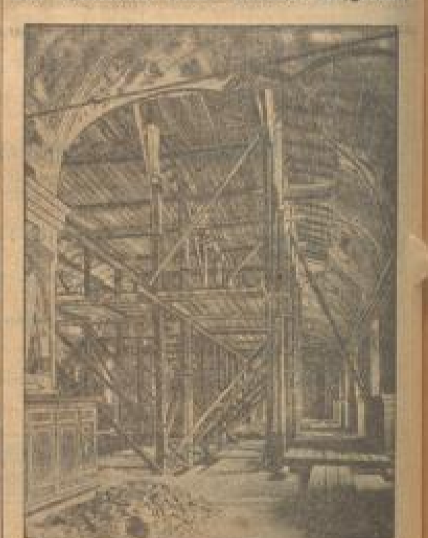
Ein Bild von den Restaurierungsarbeiten im Saal der Väterungen
