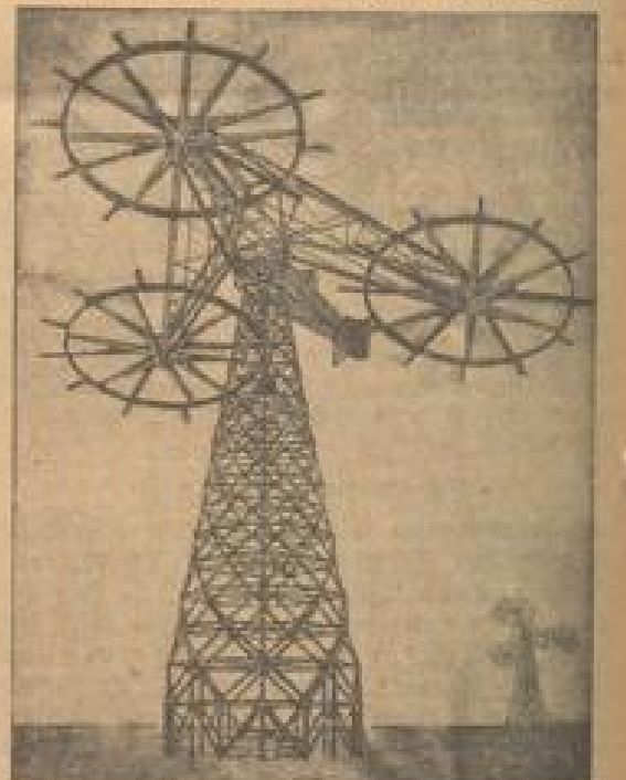
Einer der geplanten Windkrafttürme
