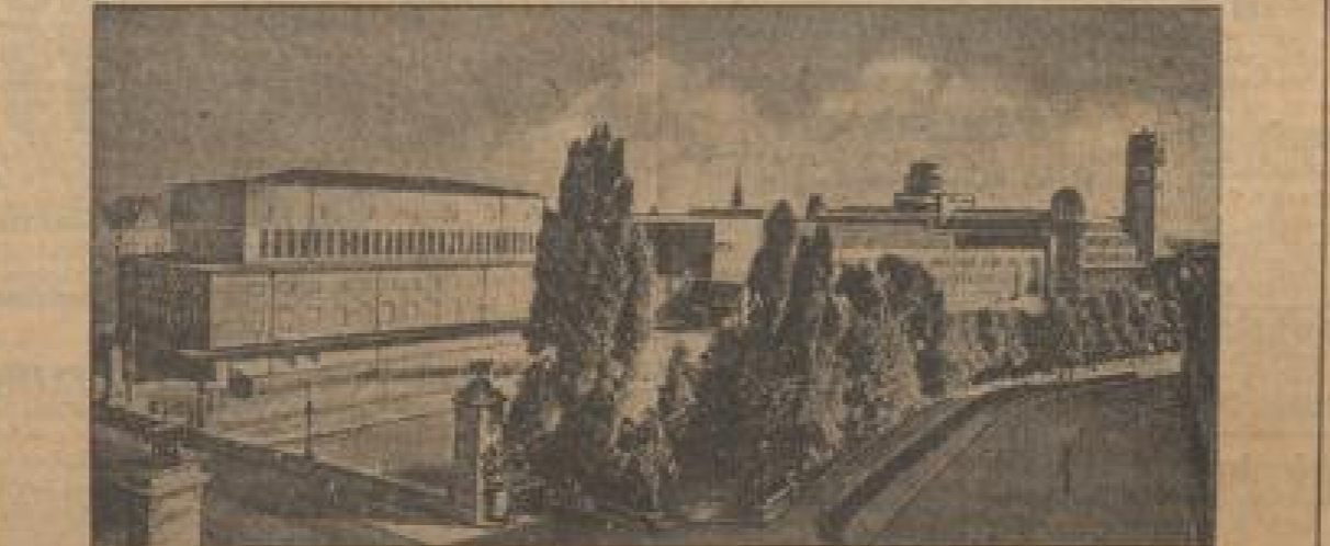
Der neue Erweiterungsbau des Deutschen Museums in München, in dem die Bibliothek des Museums untergebracht ist. Der Bibliotheksbau befindet sich in der Mitte zwischen dem Ausstellungsbau (rechts) und dem Kongress-Saal.
