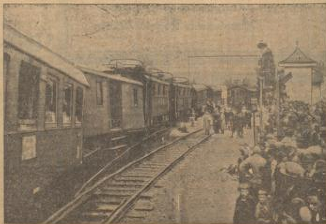
Blick auf die beiden ineinandergesfahrenen Züge
