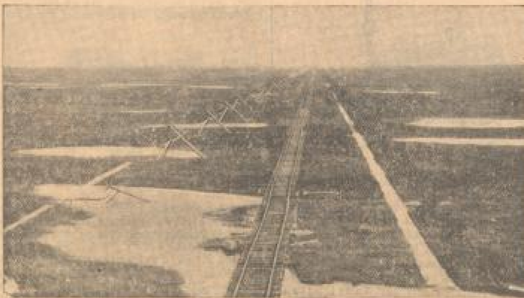
Blick auf die Schienenbrücke
