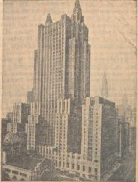
Das Waldorf-Astoria-Hotel in New York, das größte Hotel der Welt, das mit allem notwendigen Luxus ausgestattet ist und erst im vorigen Jahr eröffnet wurde, wuchs sehr unter Geschäftsaufsicht gebaut werden. Auf dem Bild sind auch die beiden neuen, noch zu erbauenden Türme zu sehen, die dieses Hotel jenen überlegen.
