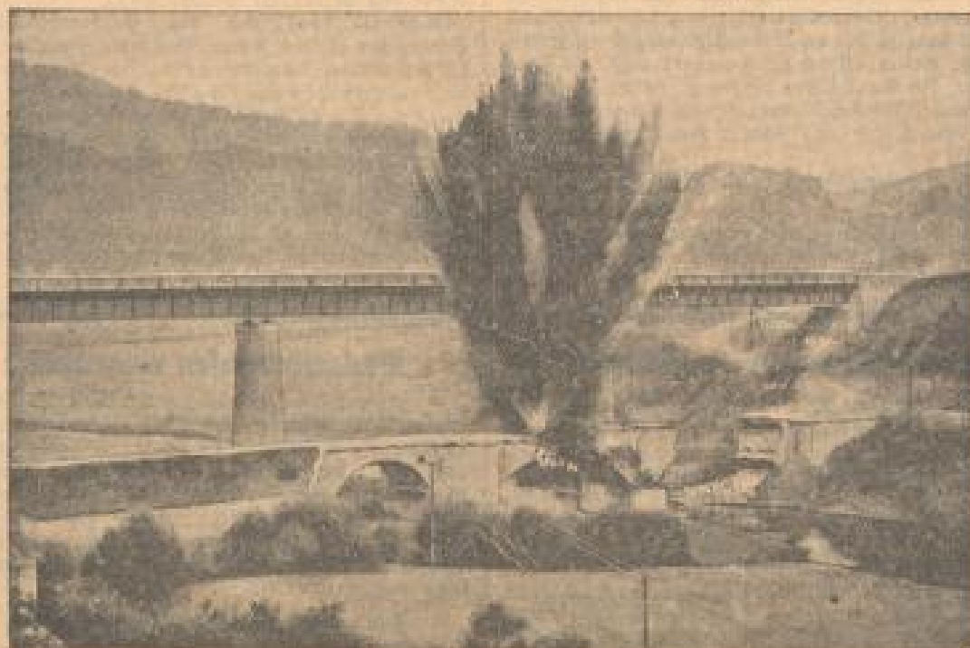
Die Sprengung der Saalebrücke unweit Gottleubsdorf (Thüringen).
