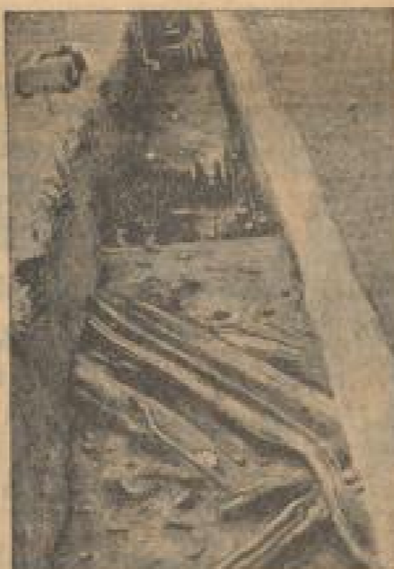
Reihe einer Holzbrücke im Luchgraben
