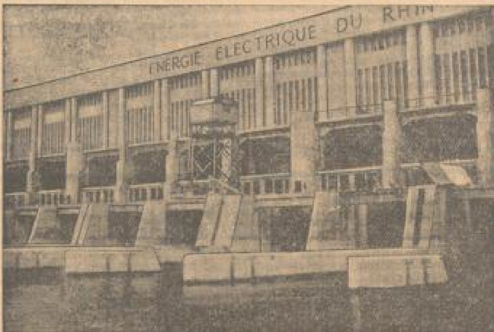
Blick auf das riesige Elektrizitätswerk in Remb.
