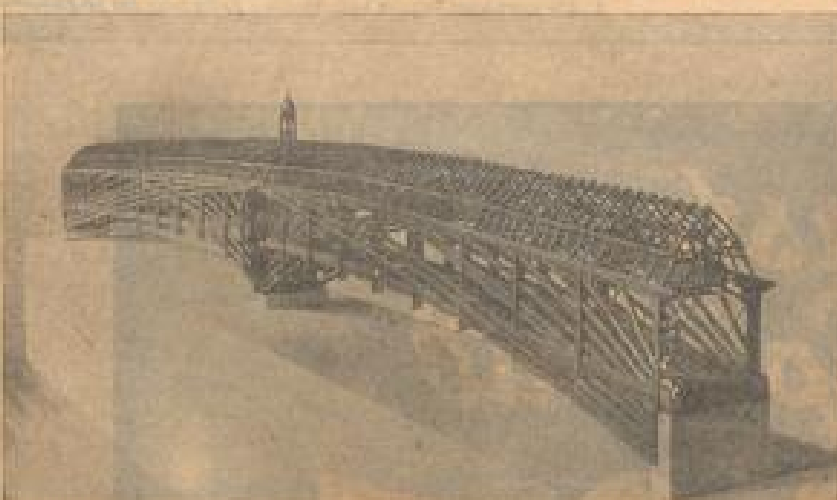
Modell der Grabenmann-Brücke von Schaffhausen (Holzbrücke), 1798 von den Franzosen zerstört
