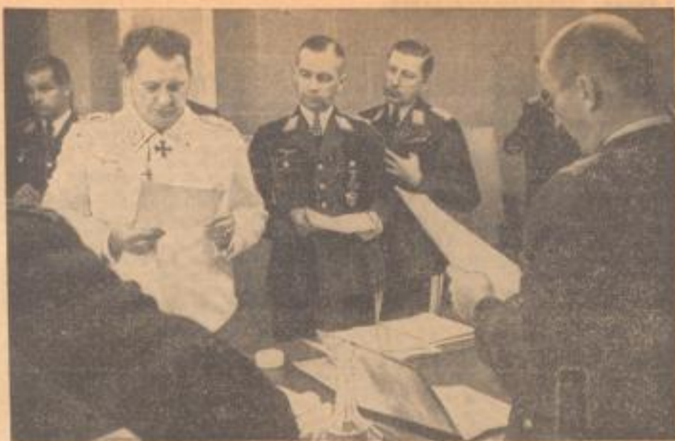
Bei der Befehlsausgabe für den Einsatz im Osten
