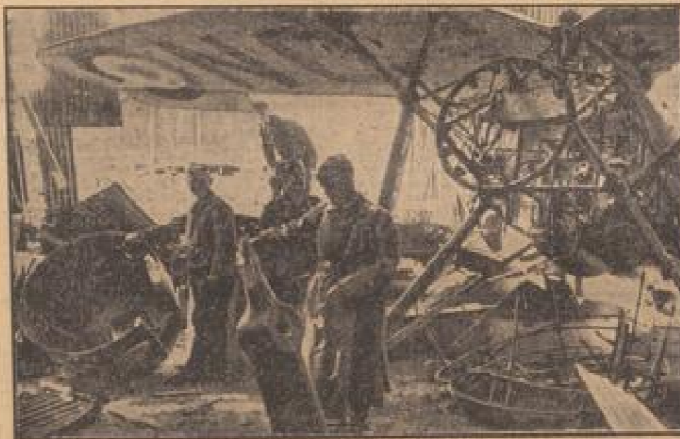
Aufräumungsarbeiten in Frankreich.
