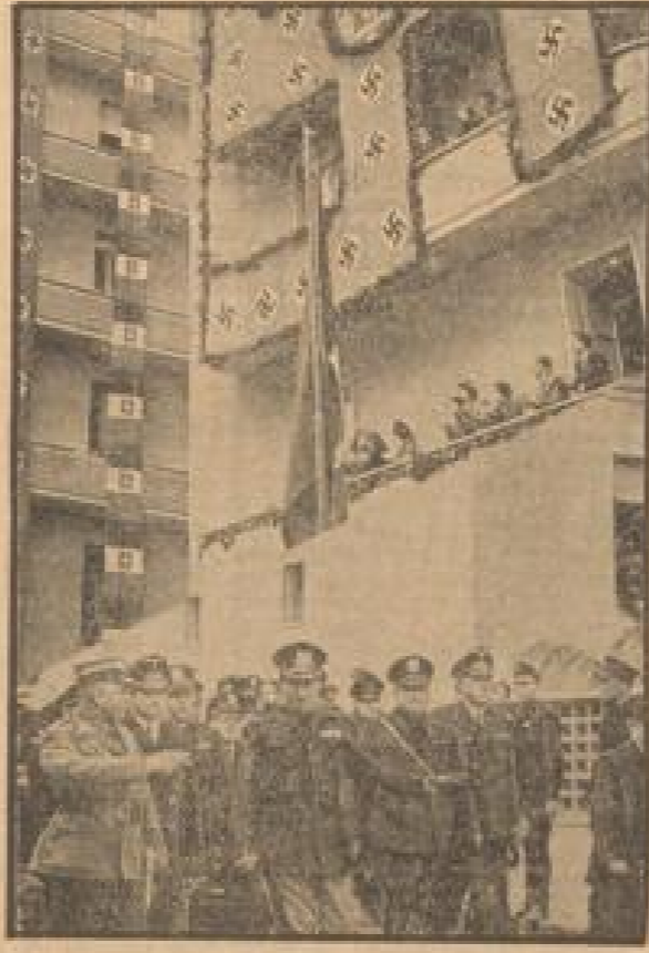
Reichsarbeitsminister Feldie besuchte Neapel und besichtigte die dort vor dem Krieg erbauten Hochhäuser. In einem der Hochhäuser wurden die Kaserne für die Weidenerzeugung fertig gestellt. (Presse-Gesinnung, Sonder-Multiplikat.)
