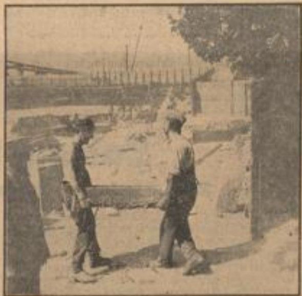
Unter Mittelbalken-Bauhebel für die Widerlager und die Flügelmannern wird ausgelassen (Foto: Müller 2)
