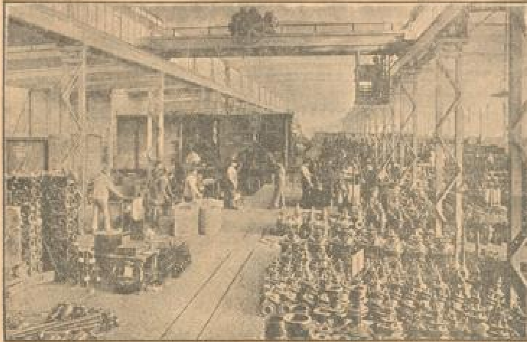
Versandhalle mit Fertigfabrikaten der Firma Bopp & Reuther.
