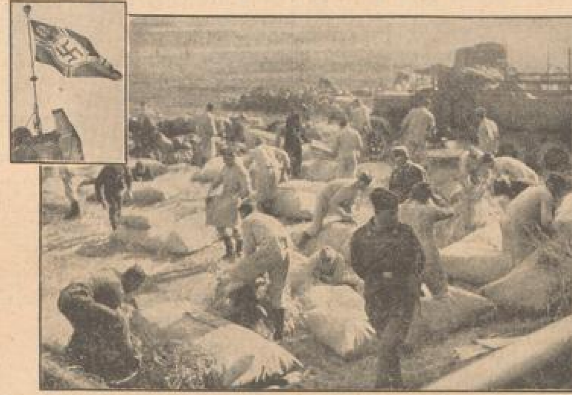
Unten: Soldaten von der Flakbatterie beim Strohsackstopfen. — Oben: Vom Turm des Schlachthof-Verwaltungsgebäudes weht die Reichskriegsflagge.
