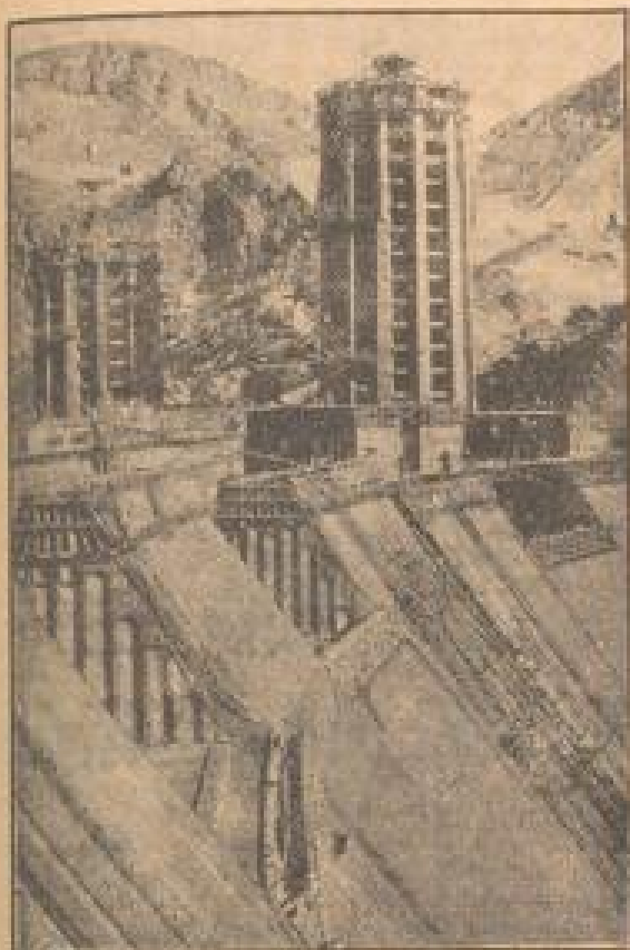
Riesige Mauer mußten für den Boulderdamm in USA errichtet werden
