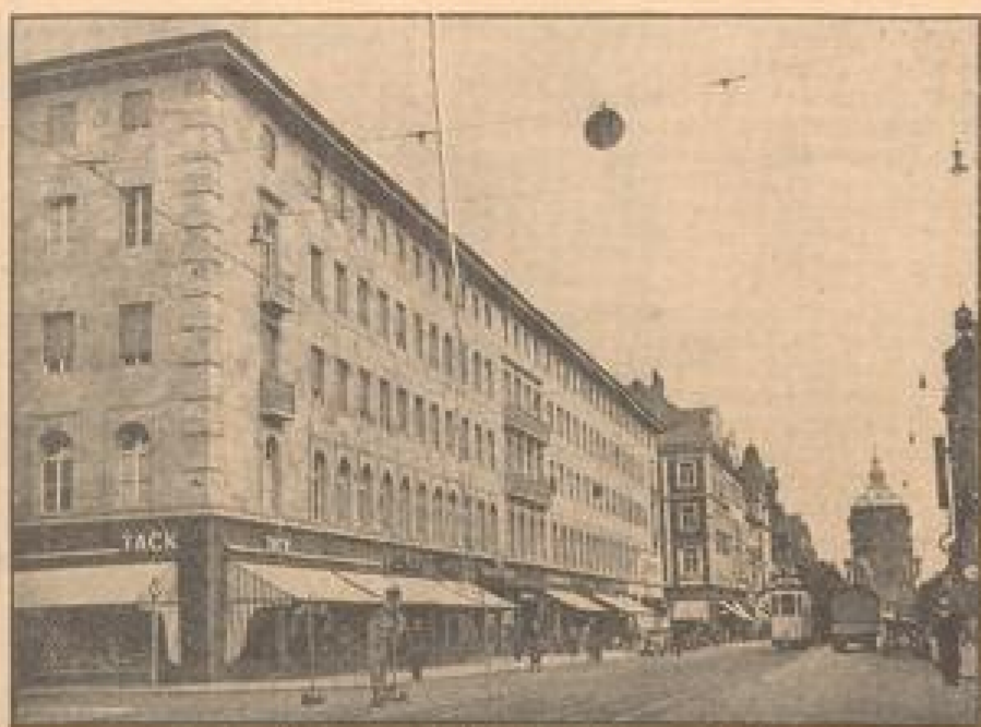
Der bereits bezogene fertige Teil der neuen Planken
