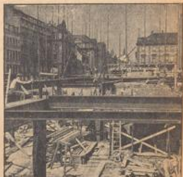
6 Wochen nach dem ersten Spatenstich
